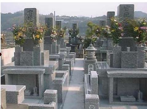
仏石・上台・下台・花立・水入は旧材を使用それ以外の石は類似した新材にて施工外柵がブロックだったのを石へ変更して
