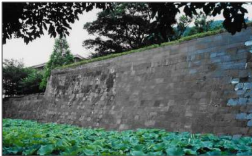
鶴丸城城壁工事 山とど石
