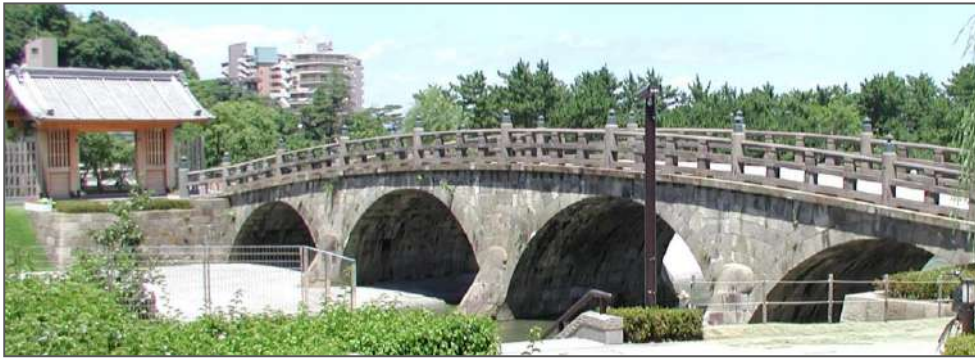
西田橋復元工事 小山田石
